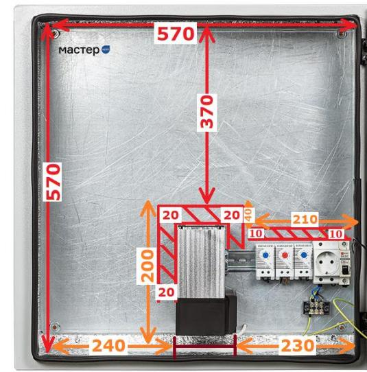
**Внимание!** Температура корпуса обогревателя во время работы превышает 70°C, во избежание повреждения аппаратуры и кабелей производите их монтаж на расстоянии не менее 20 мм от обогревателя.
