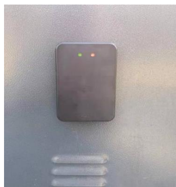
(d) Front display after installation
