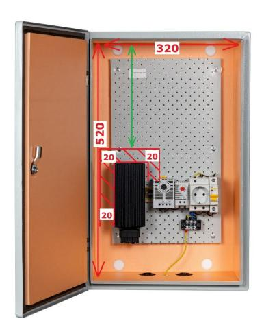
**Внимание!** Температура корпуса обогревателя во время работы превышает 70°С, во избежание повреждения аппаратуры и кабелей производите их монтаж на расстоянии <u>не менее 20 мм</u> от обогревателя.
